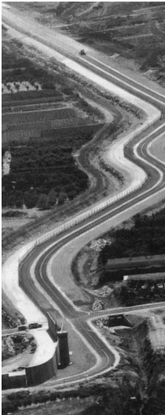
Le « mur » en construction (juillet 2003, DR)
